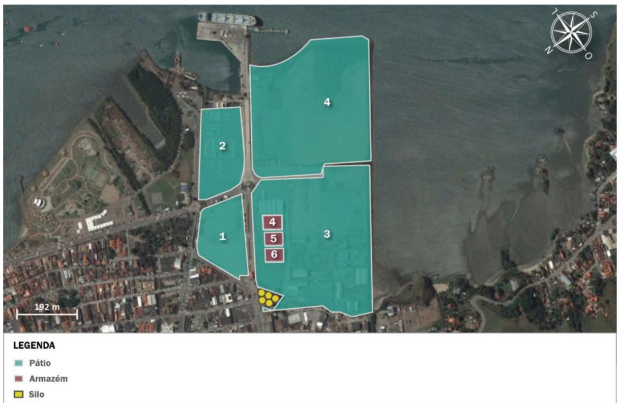
Figura 77 - Infraestrutura de acostagem do Porto de São Sebastião Fonte: Plano Mestre do Porto de São Sebastião (2018)
