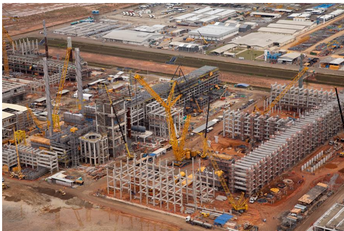
Figura 16 – Obras do COMPERJ
