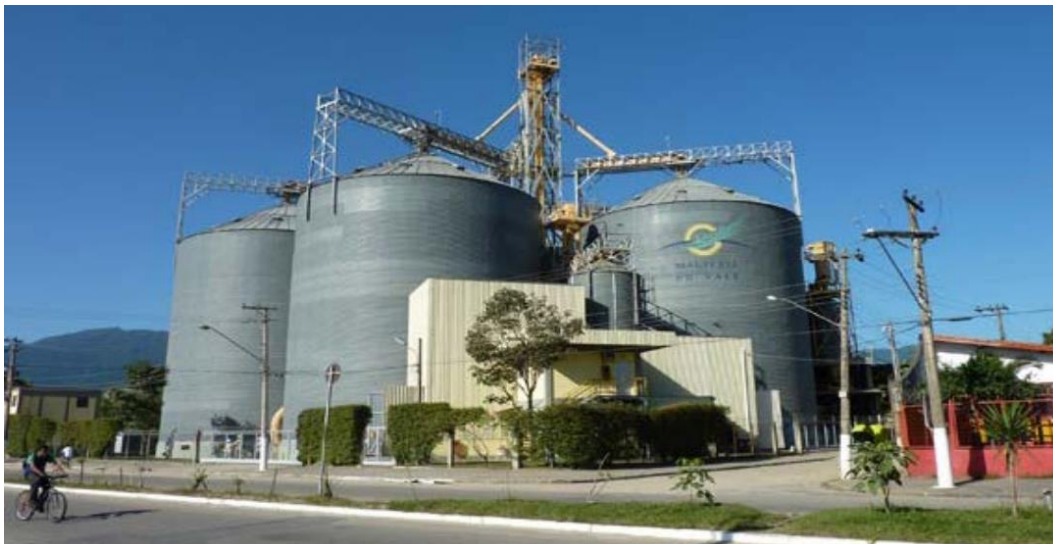
Figura 79 - Silos da Malteria do Vale Fonte: Plano Mestre do Porto de São Sebastião (2018)
