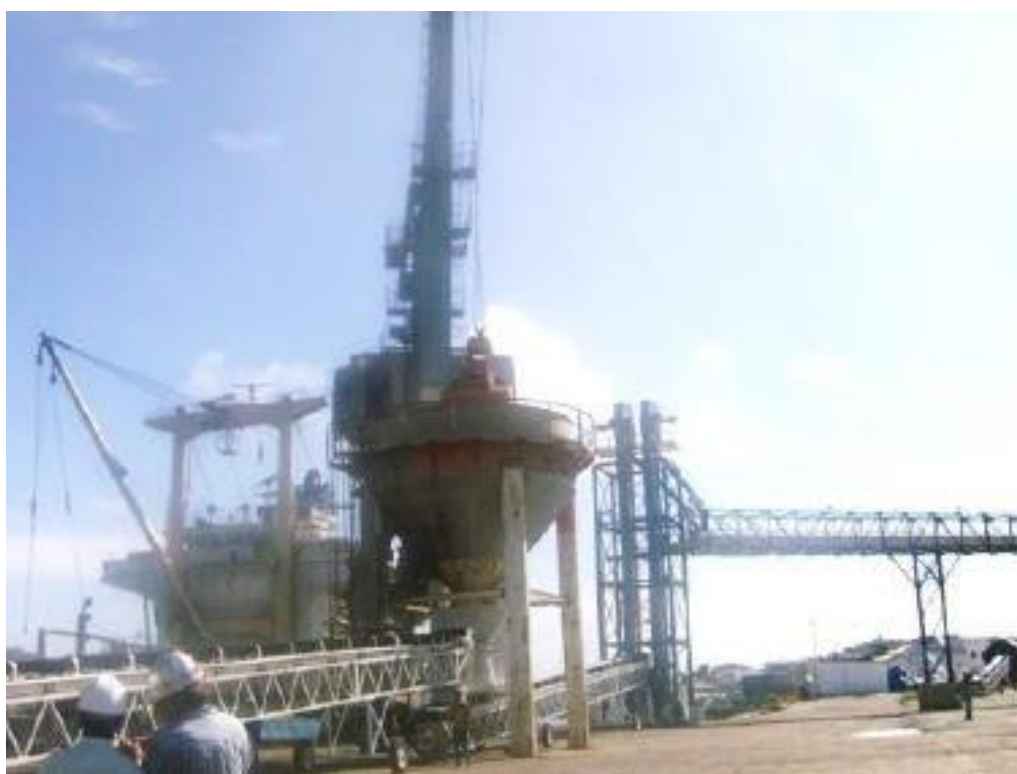
Figura 41 - Sistema de Descarregamento e Armazenagem de Malte – Porto do Forno Fonte: Plano Mestre do Porto do Forno (2014)
