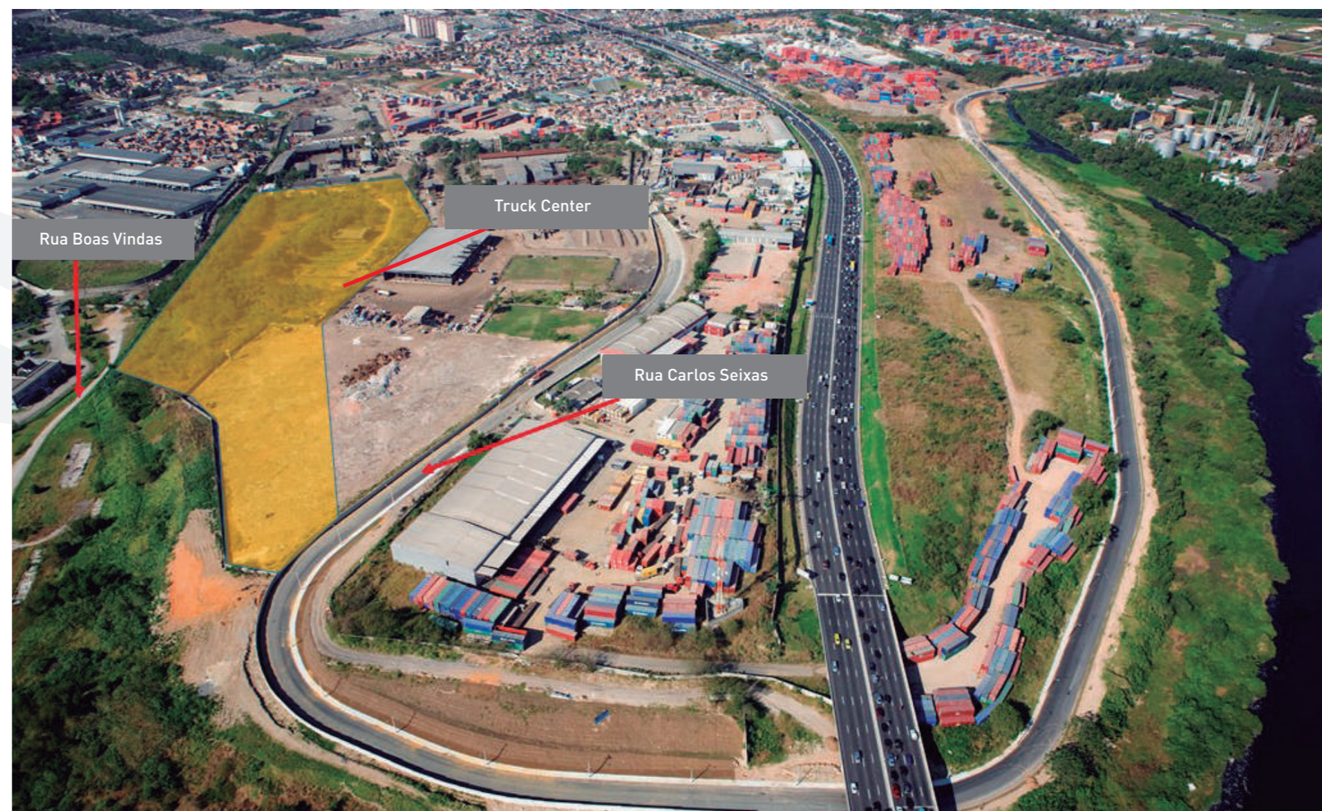
Figura 26 - Área do Truck Center
