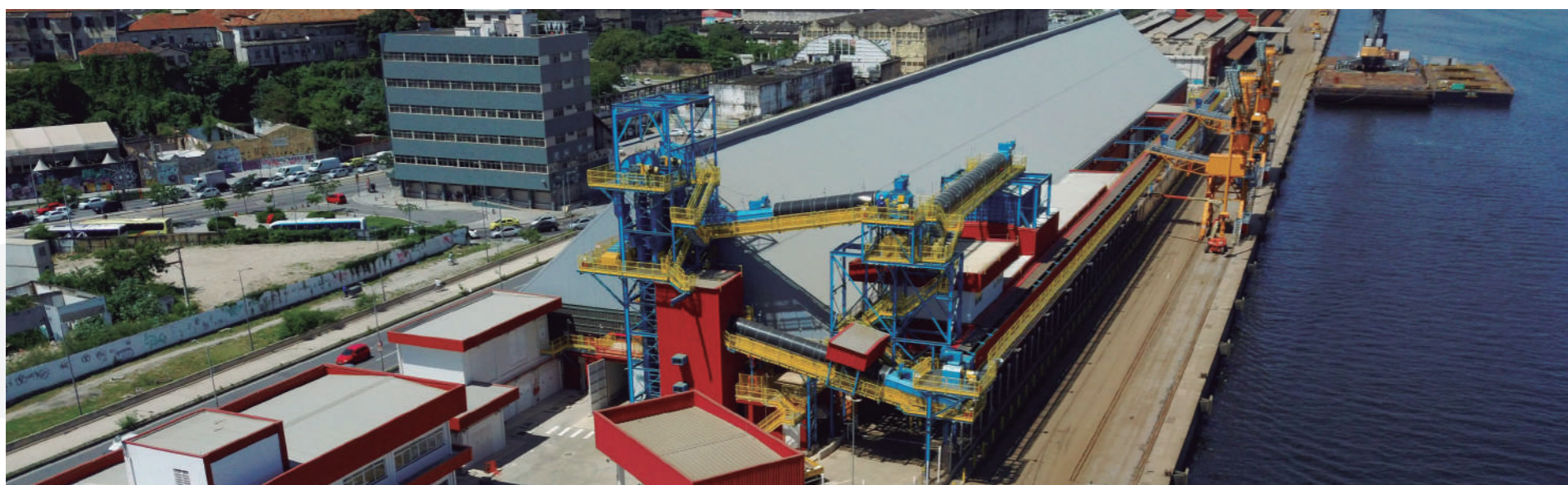
Figura 7 - Terminal de Trigo - antigos Armazéns 11 e 12
