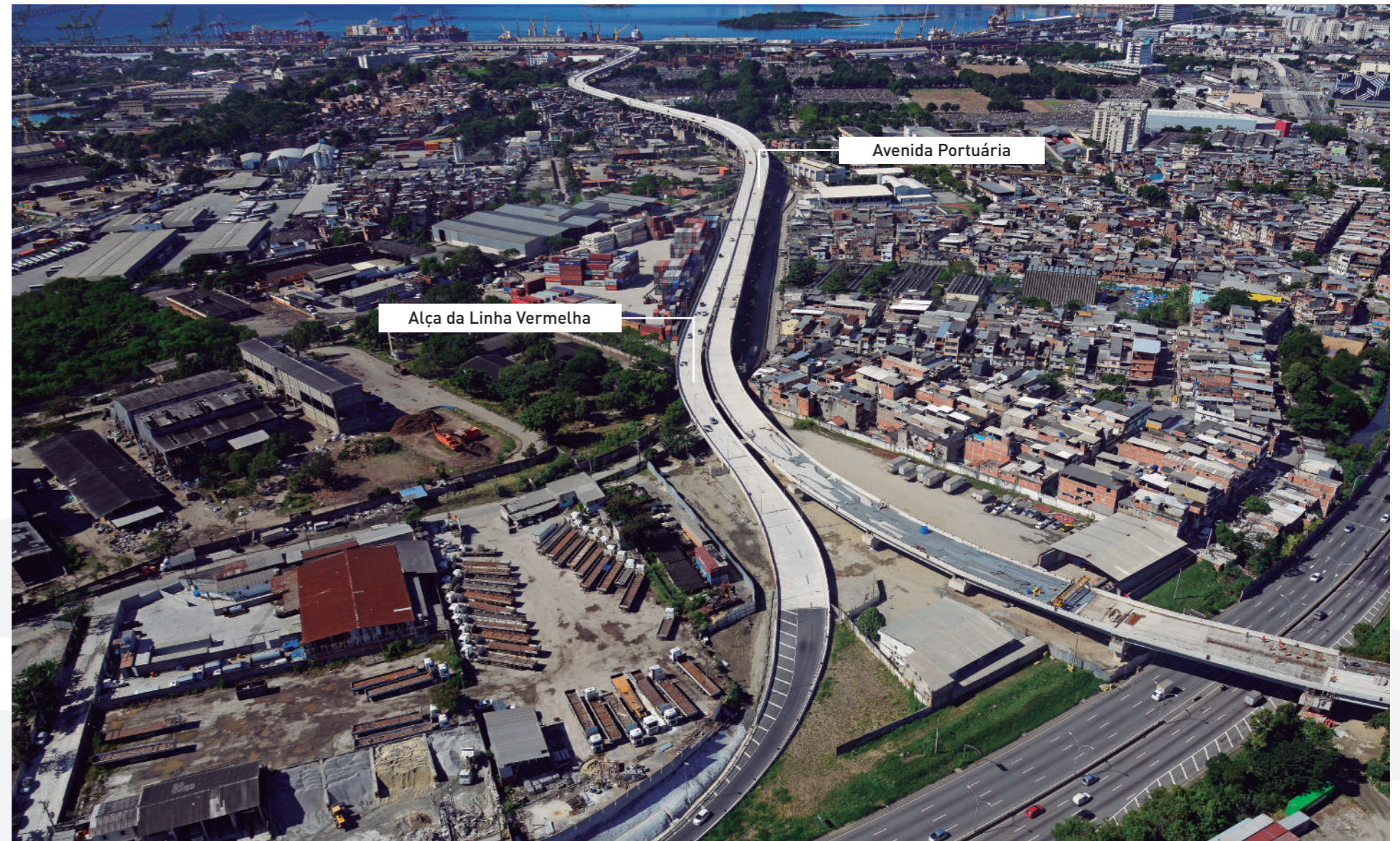
Figura 16 - Av. Portuária - obras
