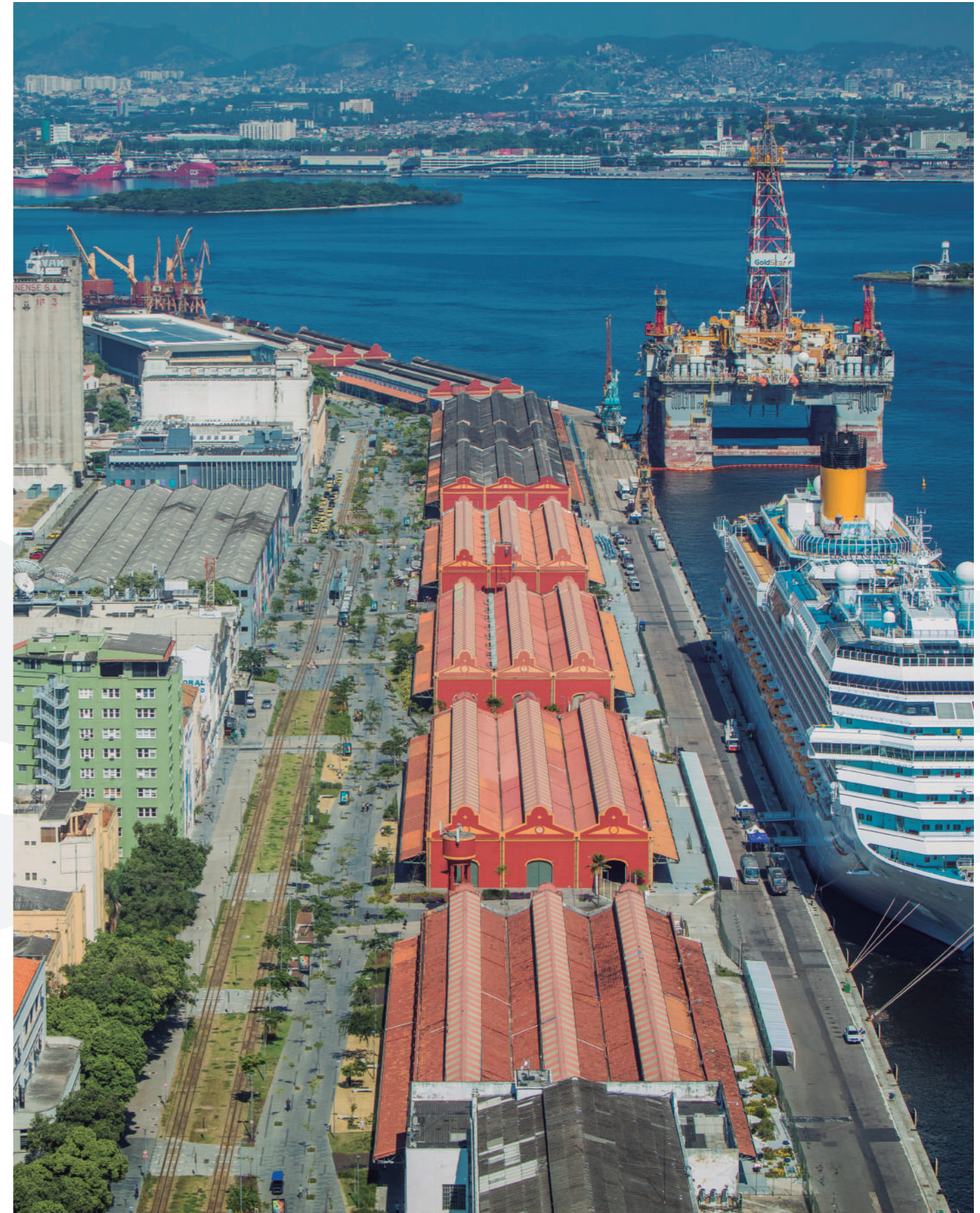
Figura 48 - Av. Rodrigues Alves - sem o viaduto da Perimetral, com Boulevard Olímpico - 2019
