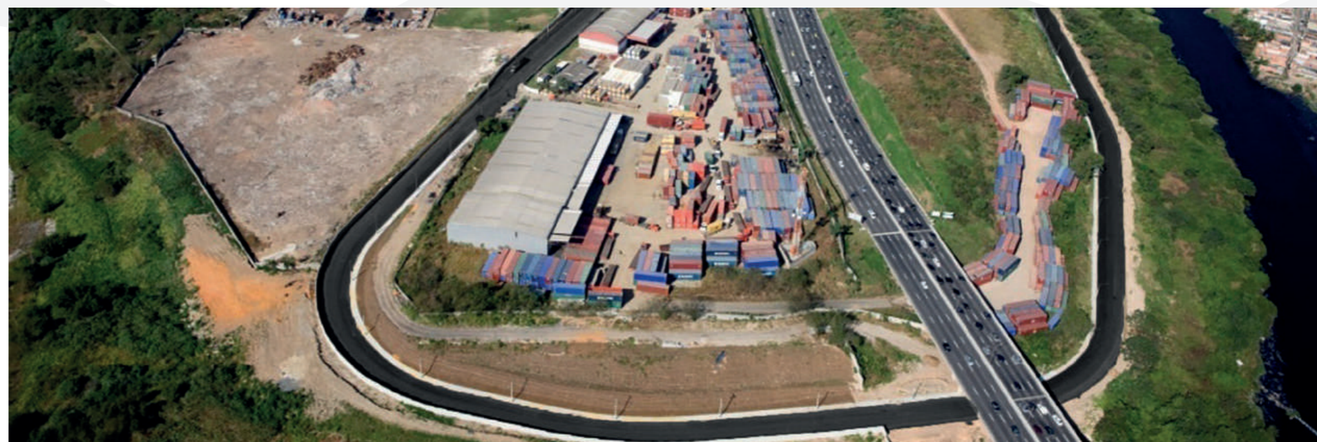
Figura 21 - Conclusão da Via Alternativa - Av Prefeito Júlio Coutinho - Setembro 2010
