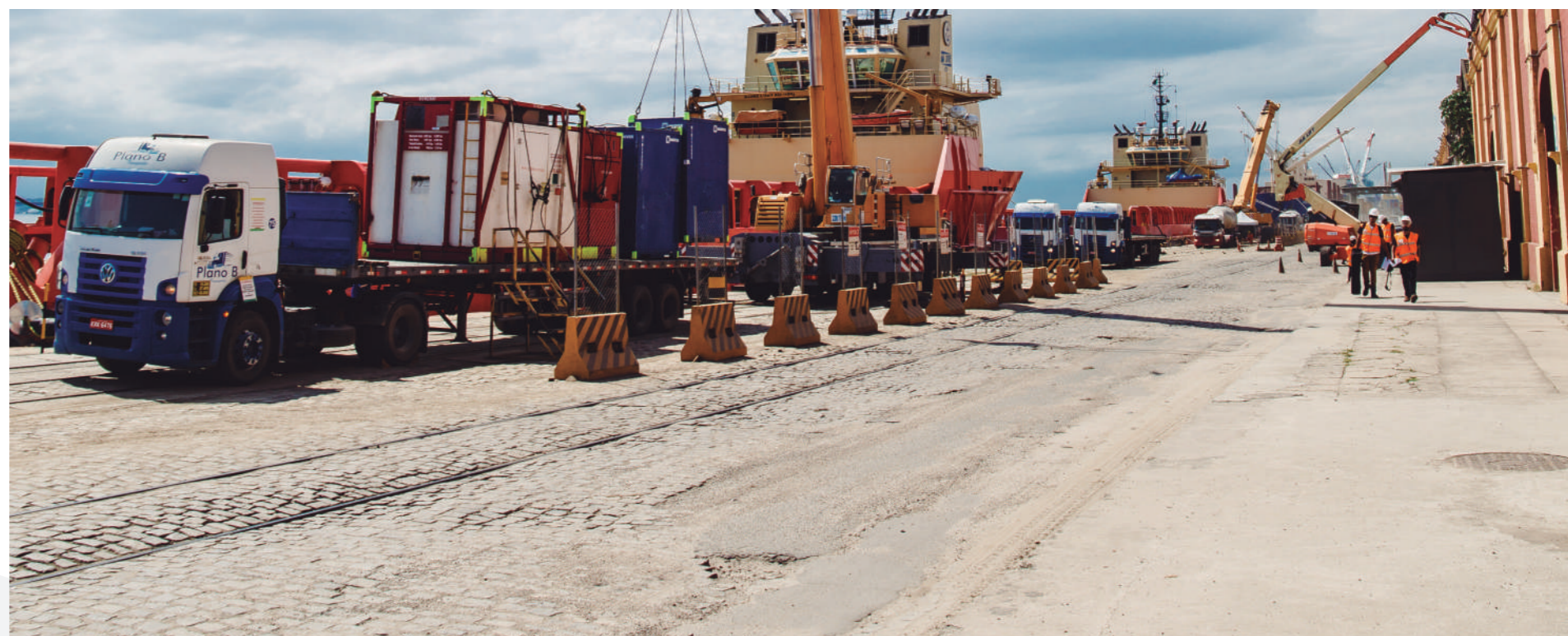
Figura 29 - Situação atual das vias internas - Cais da Gamboa
