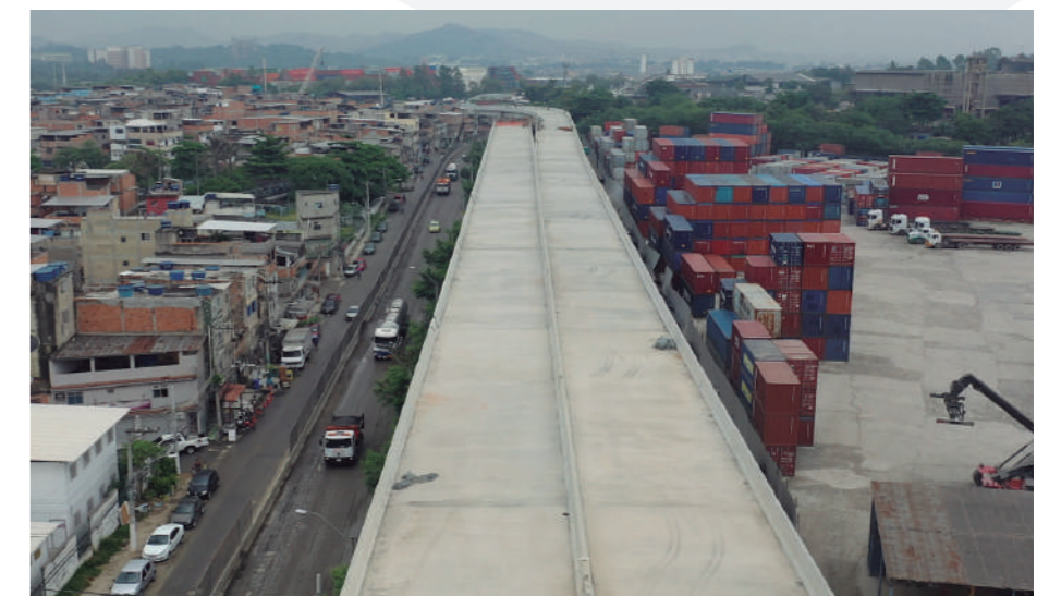
Figura 19 - Obras de Implementação da Av. Portuária
