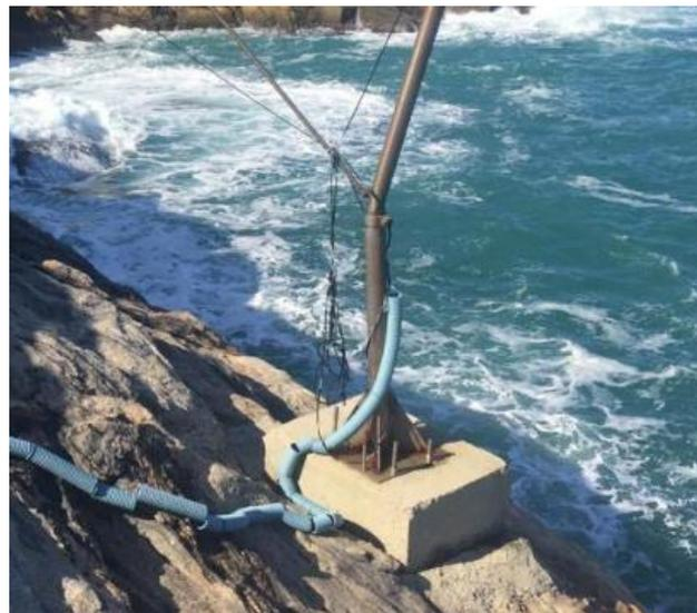
Figura 9. Detalhe da instalação da estrutura atual de suporte do marégrafo radar da Ilha Rasa, que se encontra inoperante.
