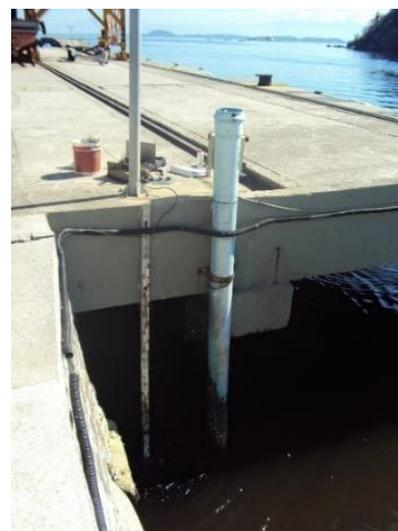
Figura 3. Tubo tranquilizador do sensor de boia e contrapeso da estação maregráfica convencional atual da Ilha do Boqueirão e que será substituída.
