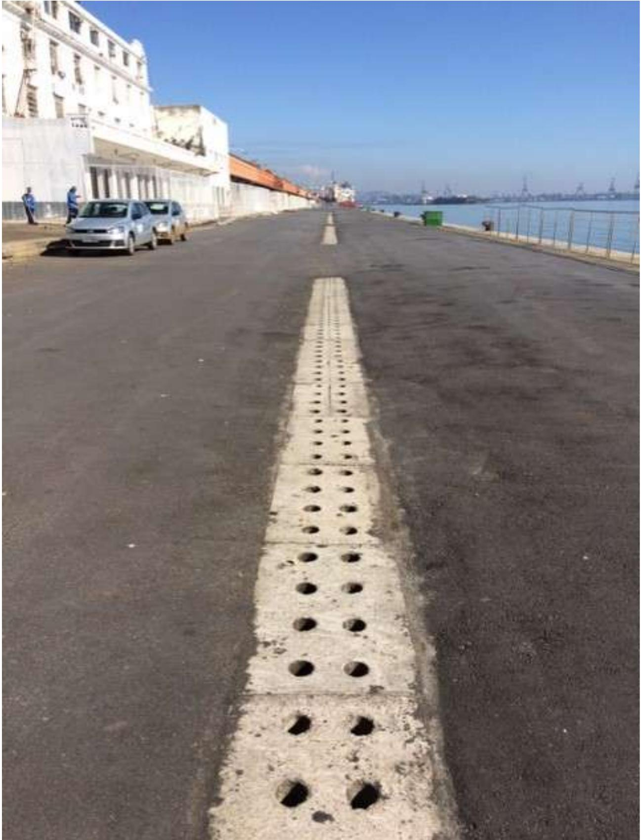
O sistema de drenagem superficial sempre foi eficiente, porém necessita de manutenções de limpeza e desobstrução, recuperações e complementação nos moldes existentes.
