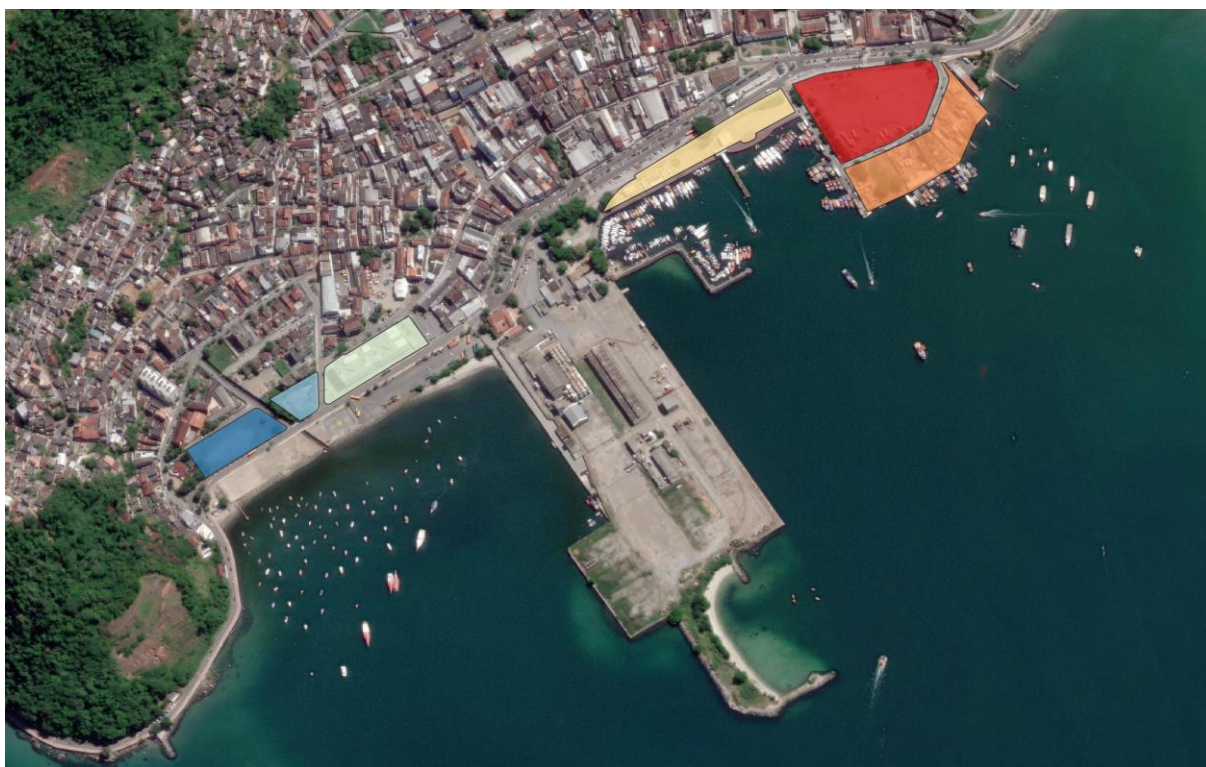
Figura 14 – Reordenamento de curto prazo – Áreas e instalações não afetadas às operações portuárias.
