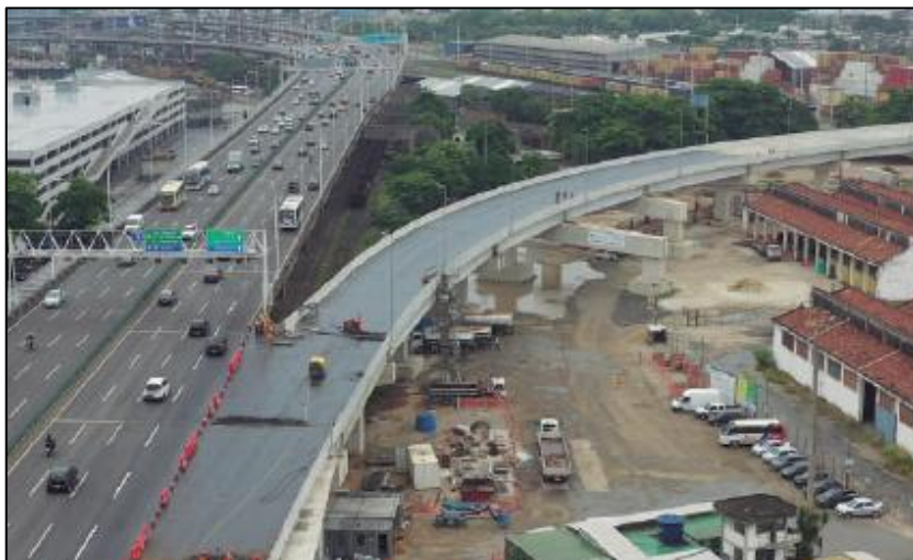
Figura 52 – Arco de Ligação da Linha Vermelha – Saída da Ponte Rio-Niterói Fonte: Porto do Rio Século XXI (Maio, 2020)
