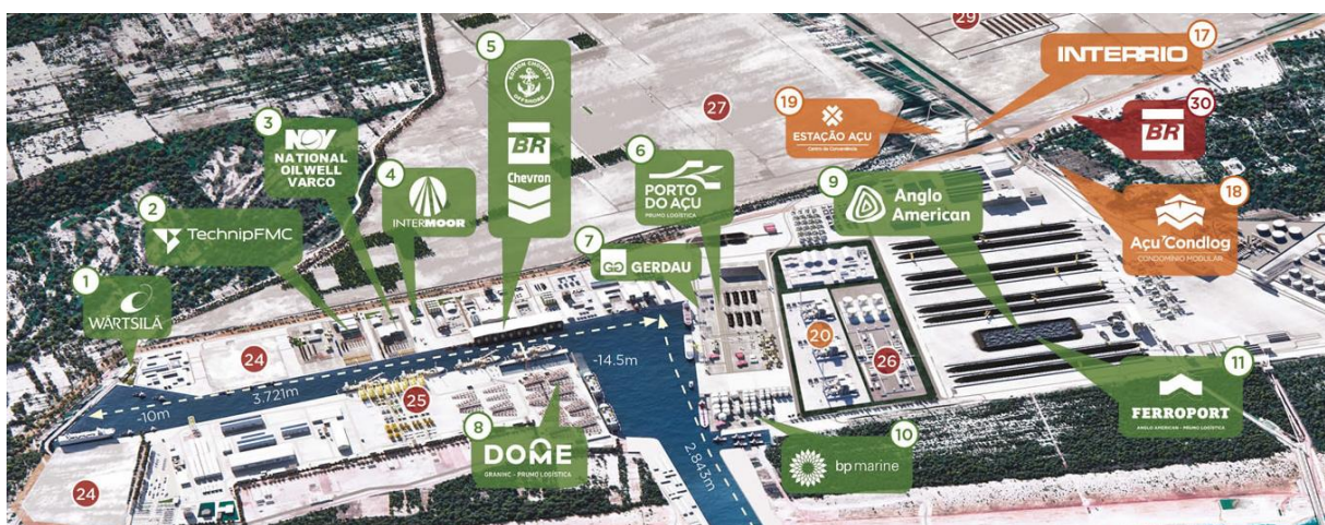
Figura 70 - Terminais Especializados – Terminal Onshore T2 Fonte: Site do Porto do Açu. Acesso em 2018
