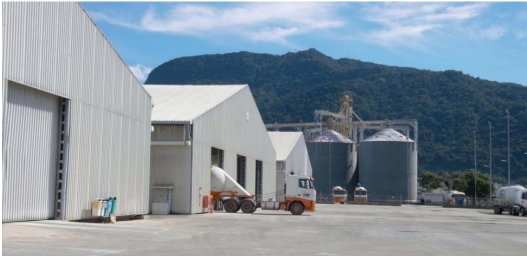
Figura 82 - Armazéns do Porto de São Sebastião Fonte: Plano Mestre do Porto de São Sebastião (2018)
