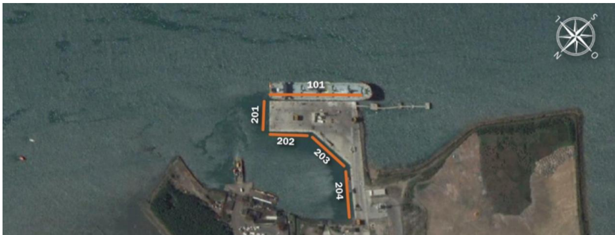
Figura 80 - Berços de Atracação – Porto de São Sebastião
