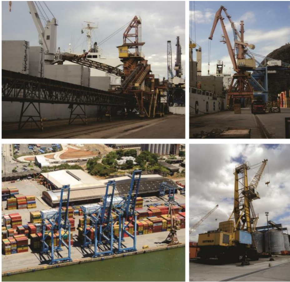
Figura 28 - Equipamentos de Cais – Porto de Vitória
