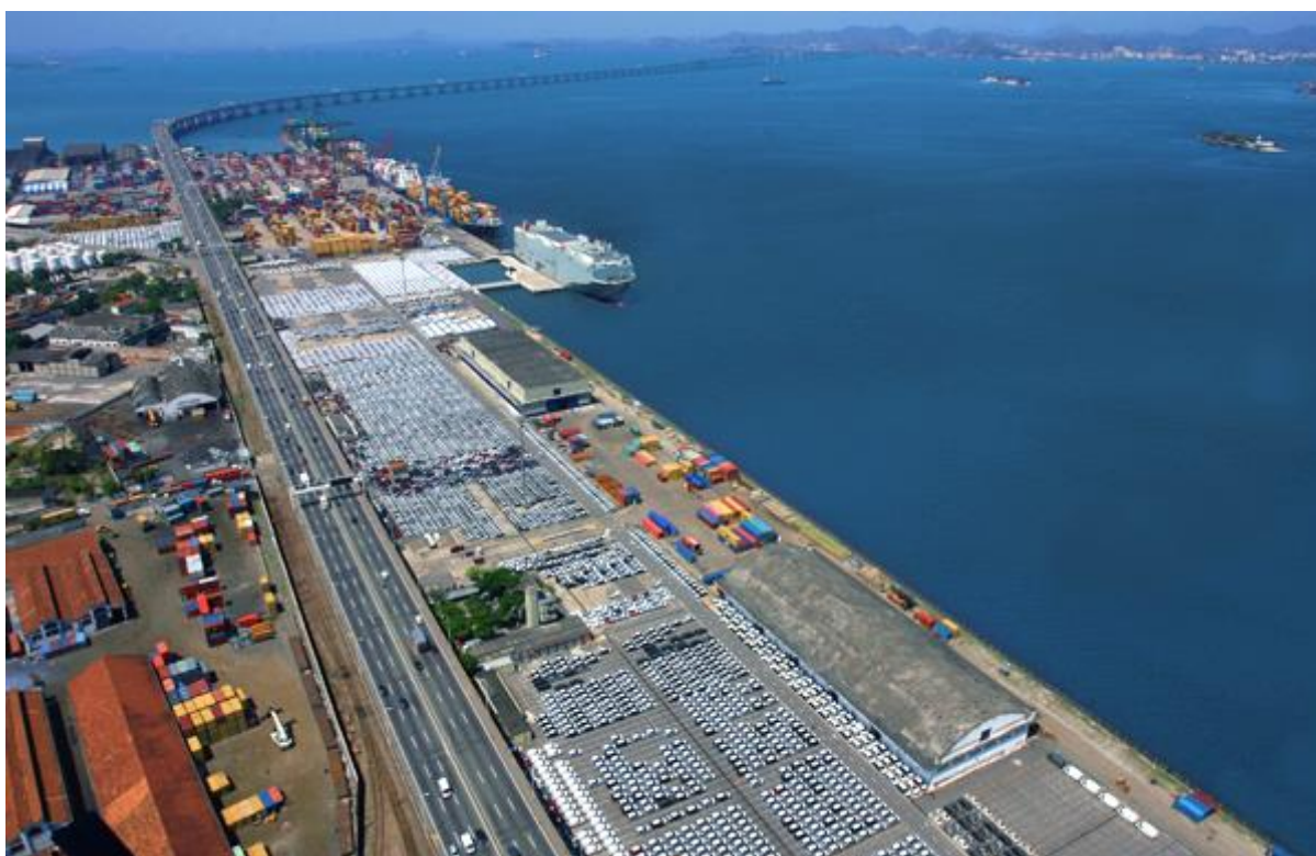
Foto 04 – Vista Aérea do Terminal da Multicar Rio
