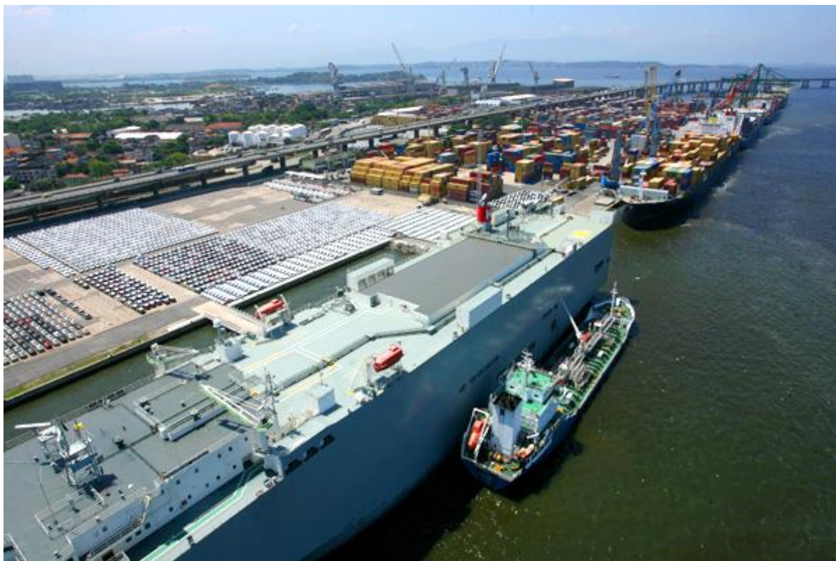
Foto 03 – Vista Aérea do Terminal da Multicar Rio
