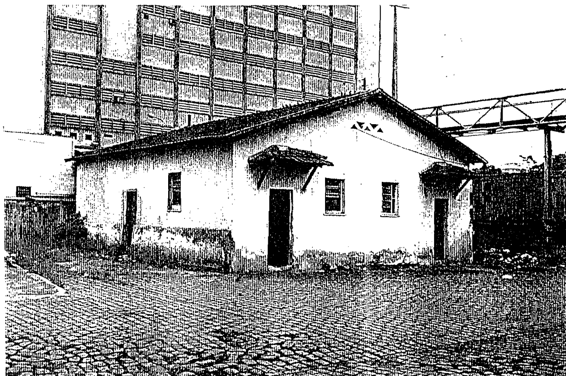
Foto 10: Construção utilizada como depósito.
