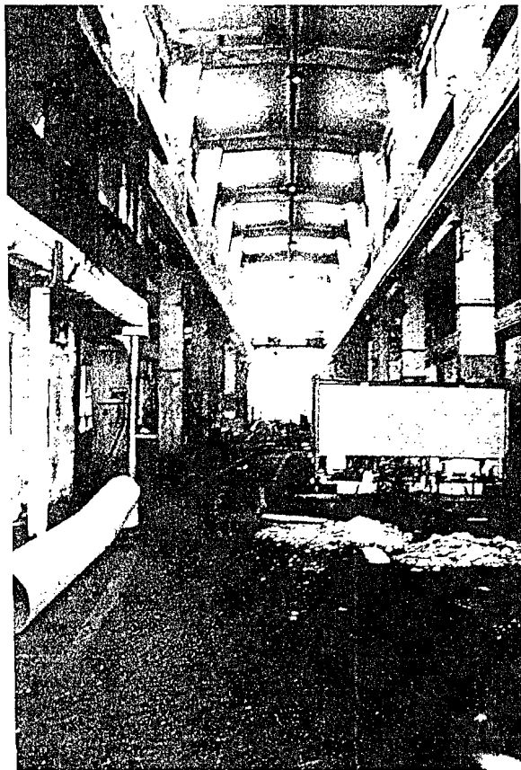
Foto 10: Interior do Armazém 3.
