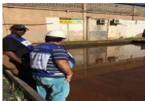
Figura 25 - Verificação de água parada no pátio interno do Porto
