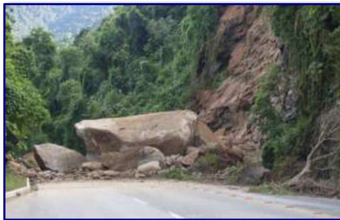
Figura 39 - Pedra desmoronada por deslizamento bloqueia todas as pistas de rodagem da BR-101 na altura de Angra dos Reis
