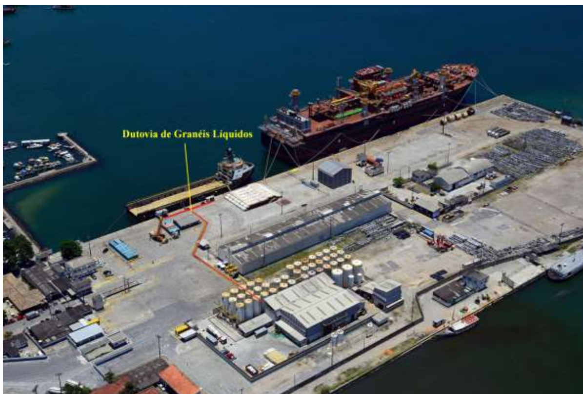
Figura 48 - Dutovia de Granéis Líquidos Fonte: CDRJ
