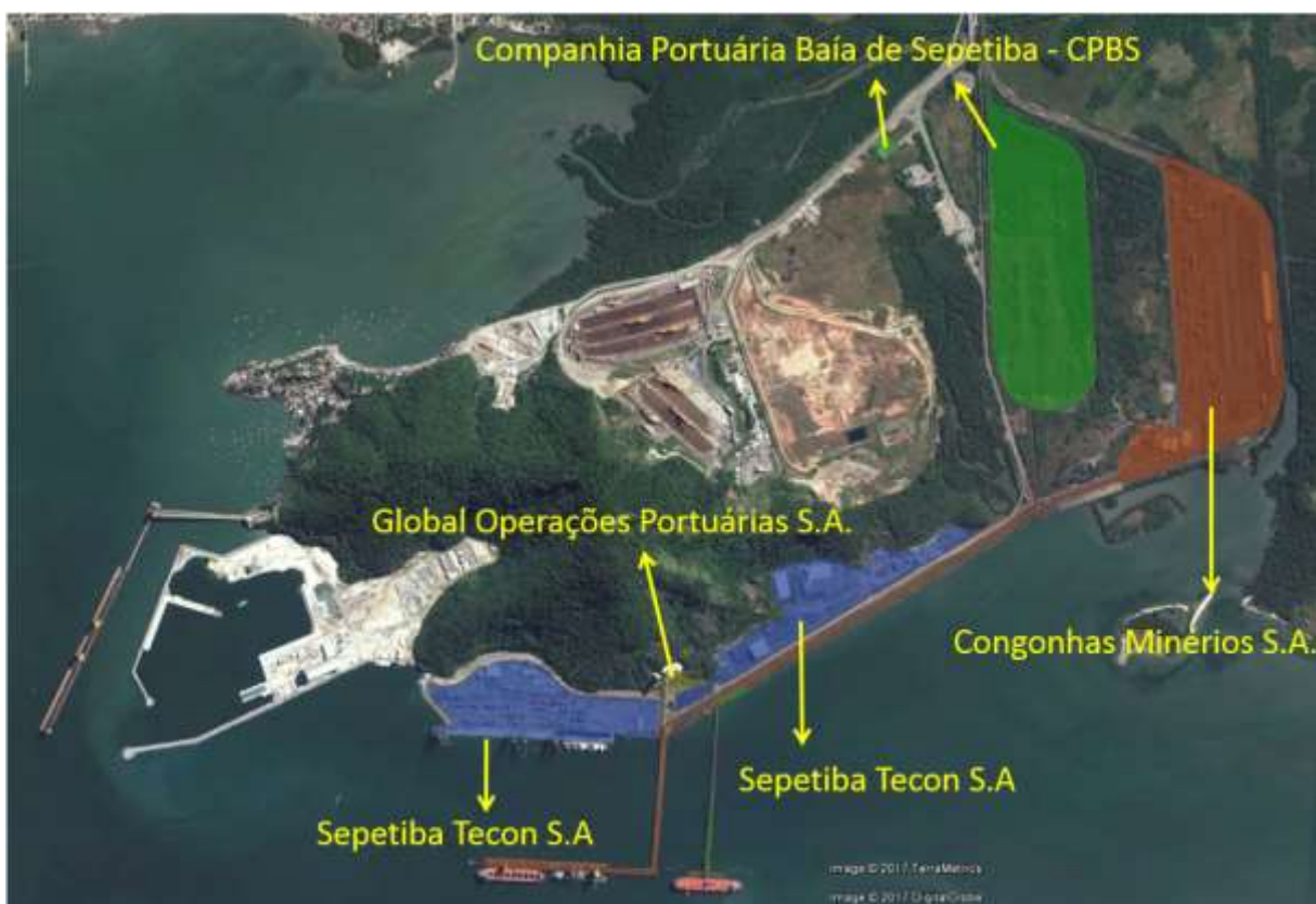
Figura 31 - Áreas e Instalações Arrendadas
