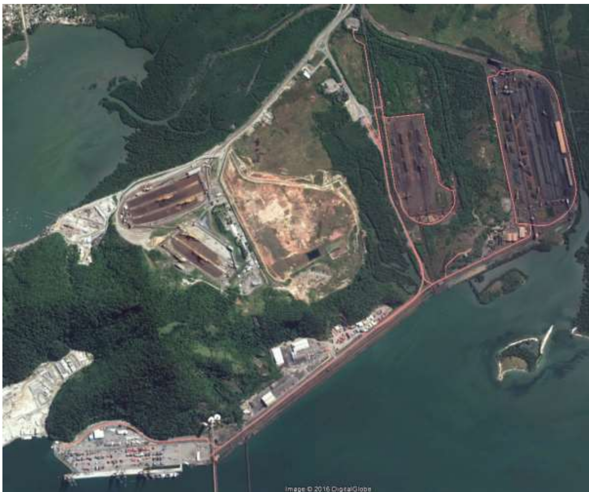
Figura 107 – Imagem aérea dos acessos rodoviários internos
