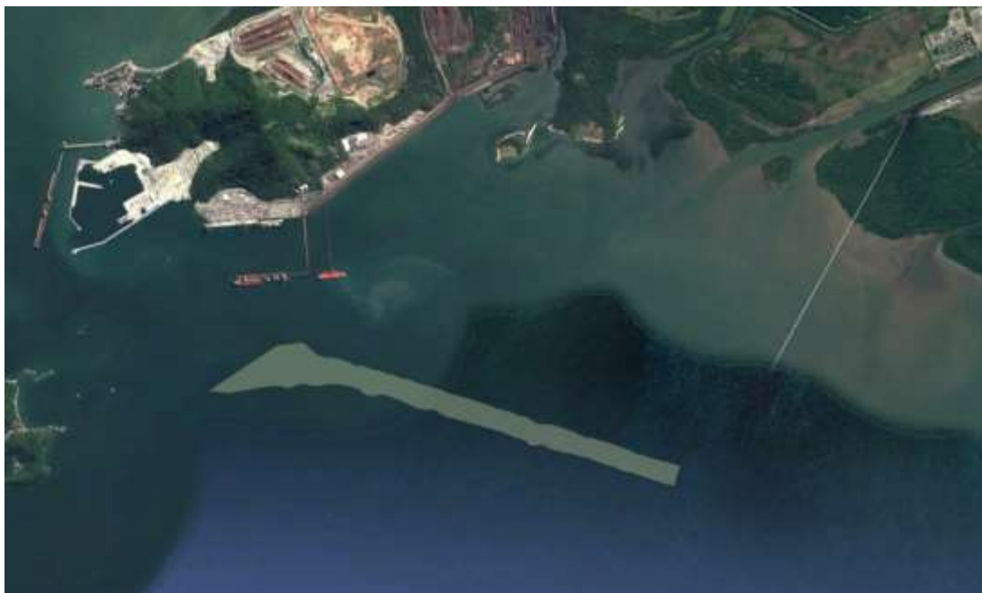
Figura 73 - Trecho do Canal TKCSA
