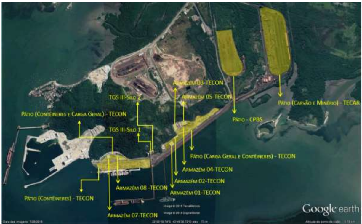
Figura 8 - Instalações de Armazenagem
