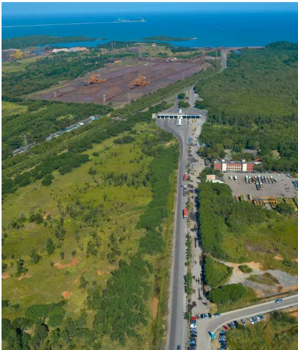
Figura 64– Via de acesso ao Porto de Itaguaí
