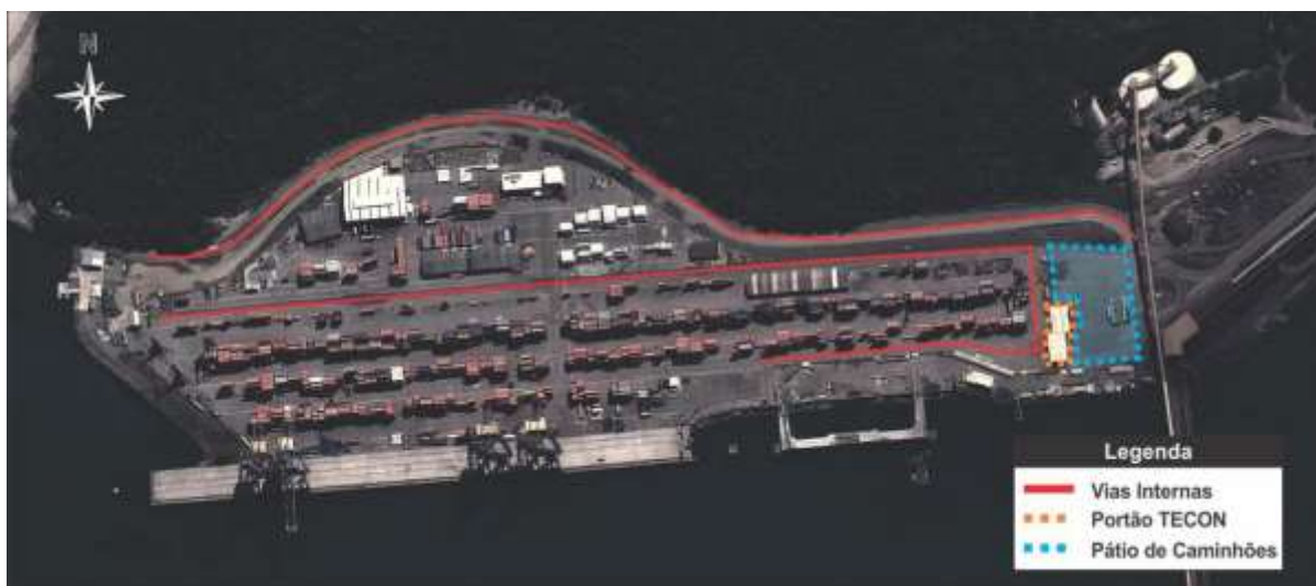
Figura 50 – Vias internas no Sepetiba Tecon
